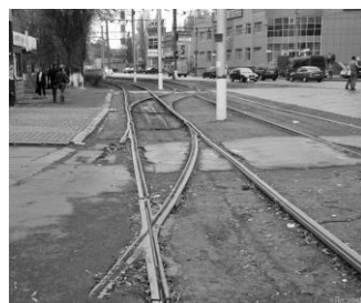
Ремонт трамвайной сети
